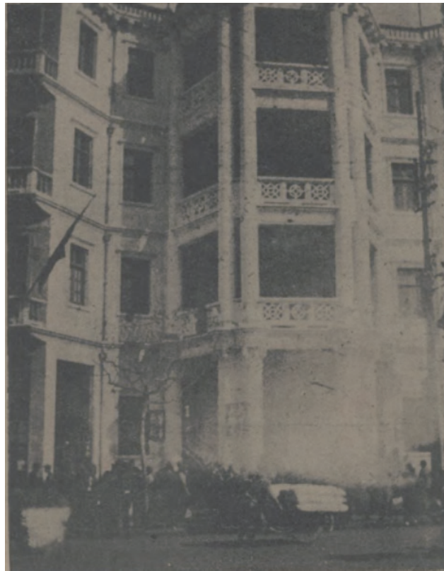
圖1 大世界遊藝場建築 [13]
